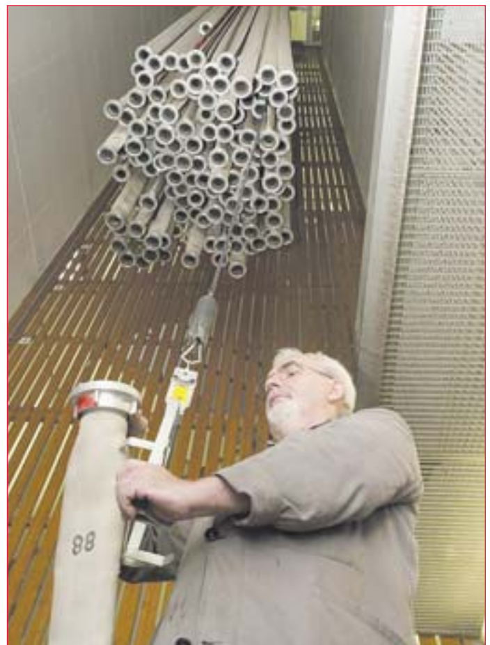
Nach dem Säubern und Prüfen werden die Schläuche im Schlauchturm getrocknet. Die FTZ sorgt für einsatzbereite Gerätschaften aller Wehren.
